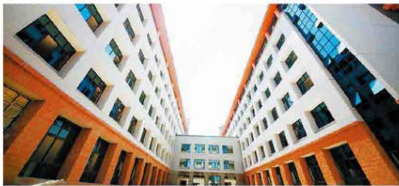
我市正在建设中的白云颐养中心
