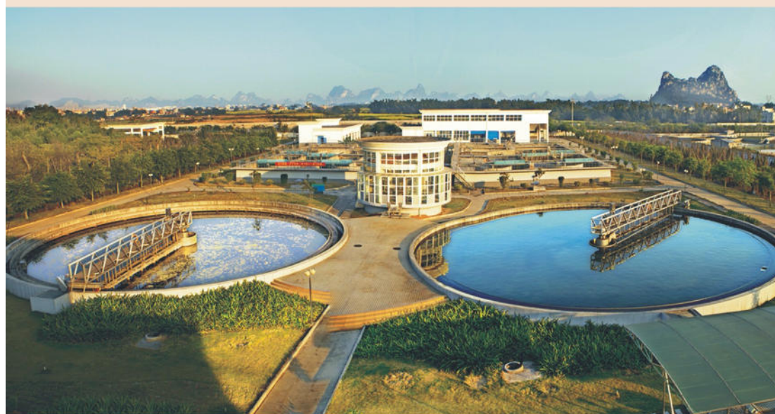
拉堡污水处理工程（梁建洪 摄）
