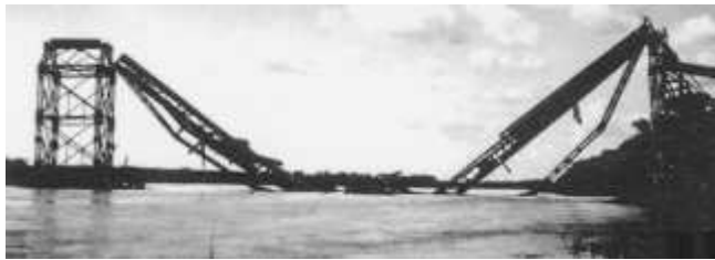
1944年11月9日,湘桂铁路管理局奉命炸毁柳州铁桥。(资料图片)
